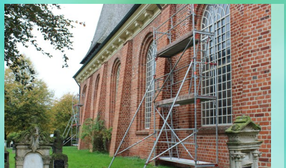
Probeentnahme für die Putzsanierung der Kirche
